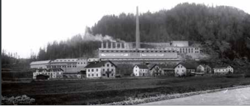
Zementwerk Bruggermühle in Kirchbichl
